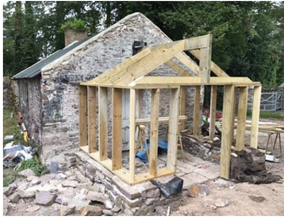
Notre prochain projet de construction...
